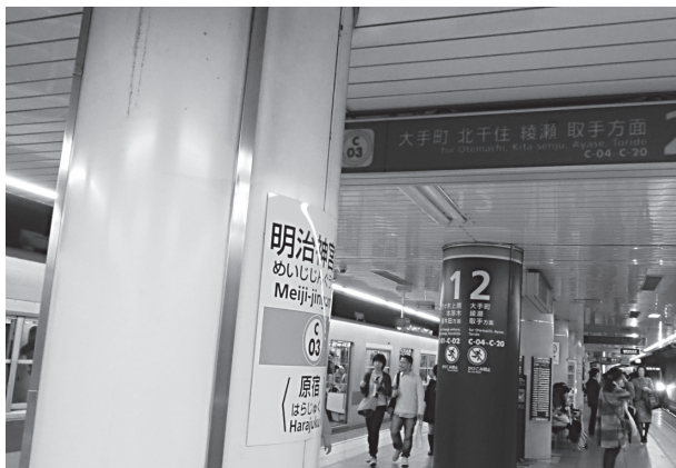
写真1 東京の地下鉄構内。5列の蛍光灯のうち、ホーム両端の2列以外の3列は管が抜かれている。しかし支障はなく、従来が無駄に明るすぎたことに気づく。また柱の看板は全く不自由なく読めるが、中の電気照明が消えたホーム案内は読みにくい。（平成23年5月28日筆者撮影）
